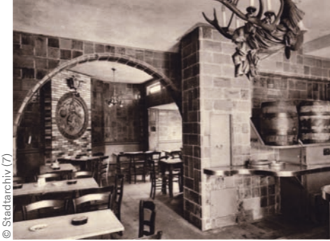
Das ehemalige Restaurant Wolfsschlucht レストラン「Wolfsschlucht」 の当時の様子
