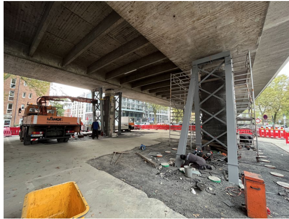
TSD-Füßler: Ertüchtigung Horizontallager Pfeiler 17
