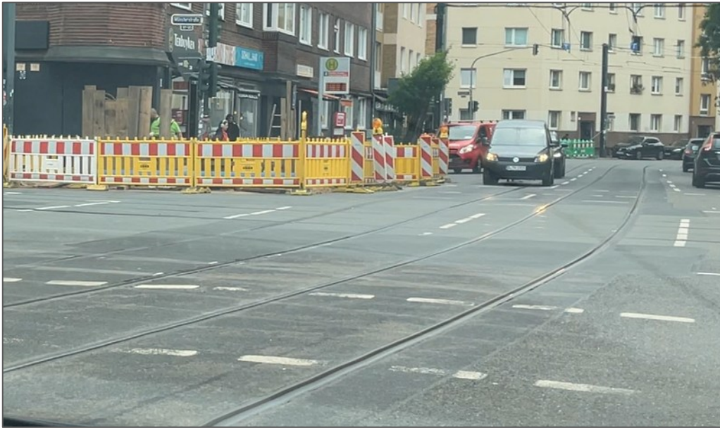
Abbildung 25: Vorhandene Gleiskreuzung auf Münsterstr. (Blickrichtung: Südosten)
