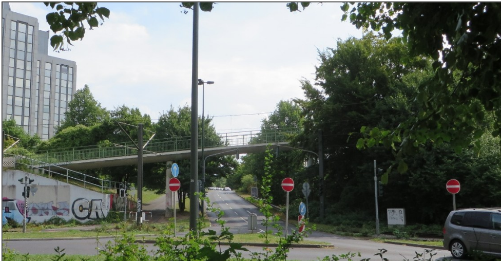
Abbildung 18: Fußgängerbrücke „Am Seestern“
