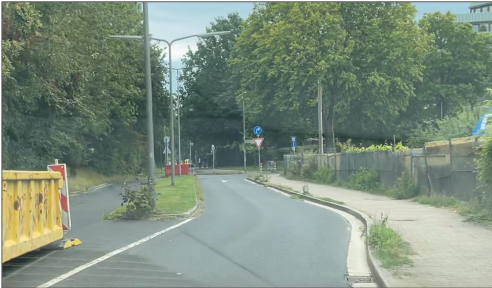
Abbildung 38: Bestandsfahrbahn Otto-Petersen-Str. (Blickrichtung: Osten)
