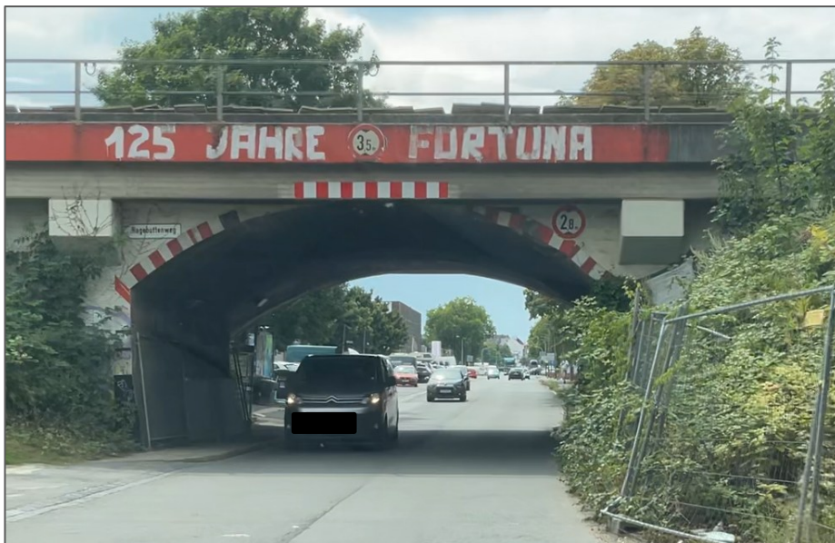
Abbildung 55 – Bahnbrücke Ronsdorfer Straße (Blickrichtung: Süden)
