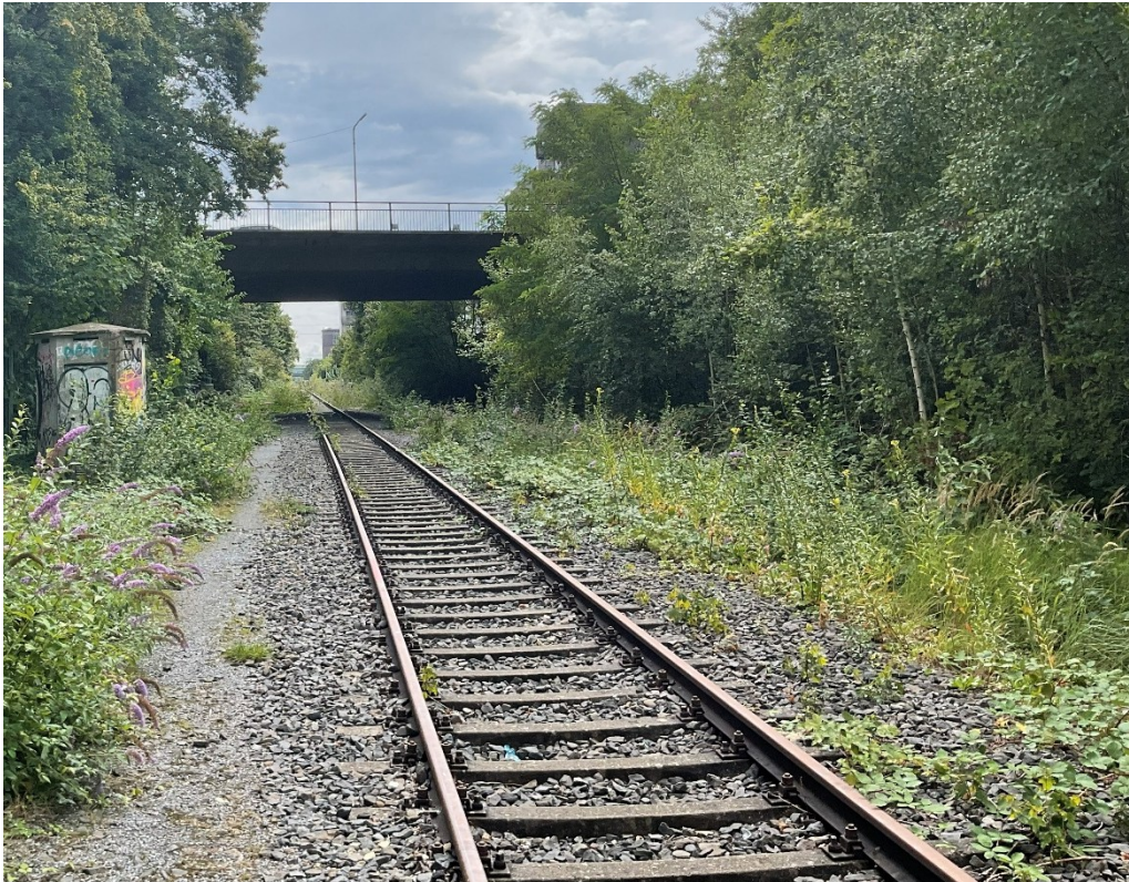
Abbildung 45: Gütertrasse im Anschluss an den Stadt-Natur-Park Flingern mit Blick auf den Hellweg (Blickrichtung: Süden)
