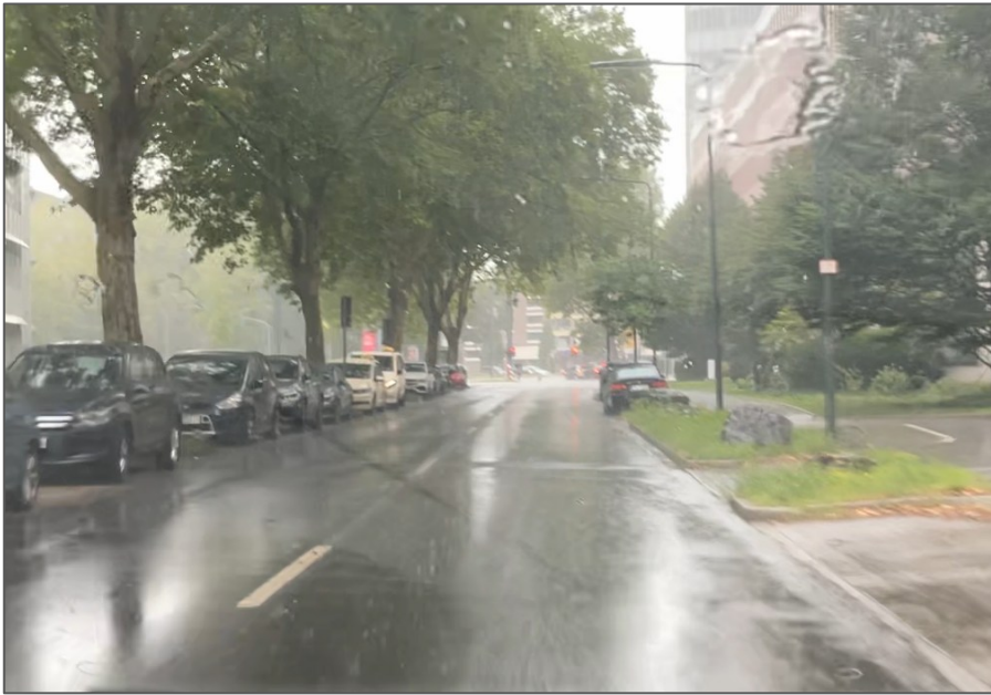
Abbildung 39: Bestandsfahrbahn Schlüterstr. (Blickrichtung: Norden)
