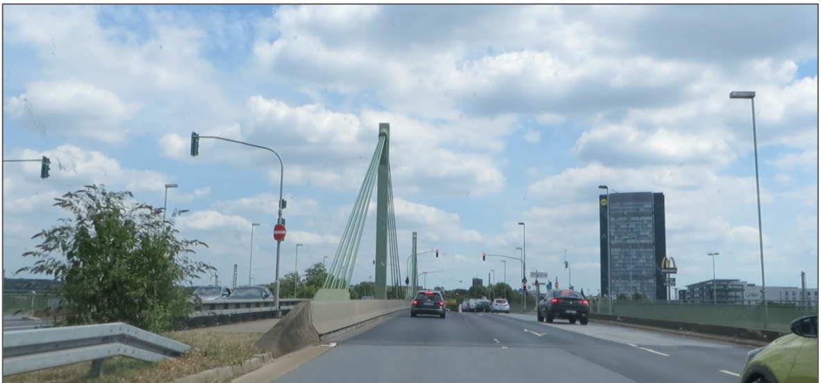
Abbildung 29: Bestehendes Brückenbauwerk über DB-Trasse (Blickrichtung: Osten)
