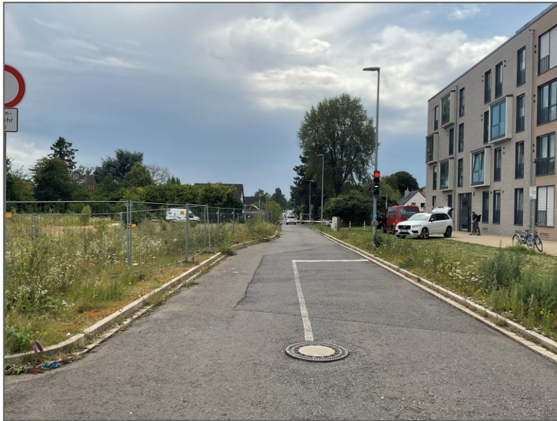
Abbildung 52 – Schrankenanlage Walter-Eucken-Straße (Blickrichtung: Süden)
