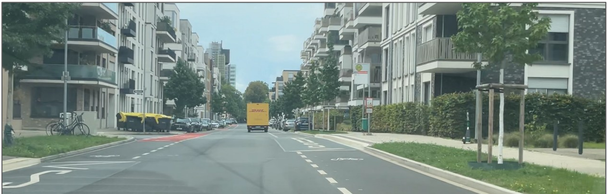
Abbildung 56: Bestandsfahrbahn Hohenzollernallee (Blickrichtung: Westen)
