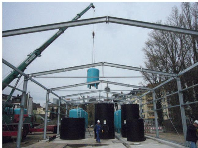
Bau Grundwassersanierungsanlage Martinstraße, Aufstellen der Behälter
