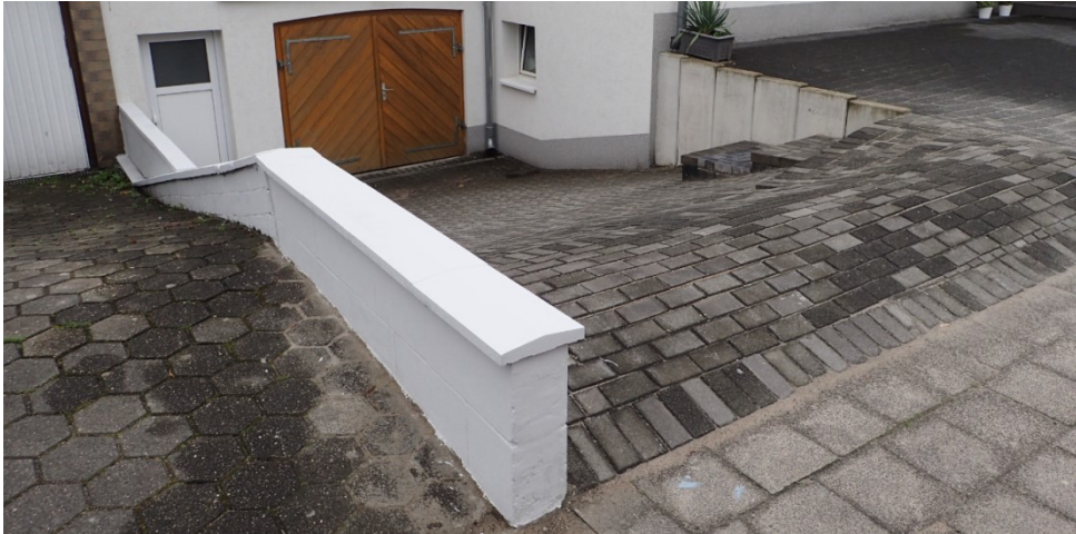
Aufpflasterung der Einfahrt
