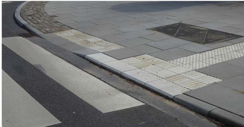
Abbildung 4-10: Differenzierte Bordhöhe an Querungsstellen
