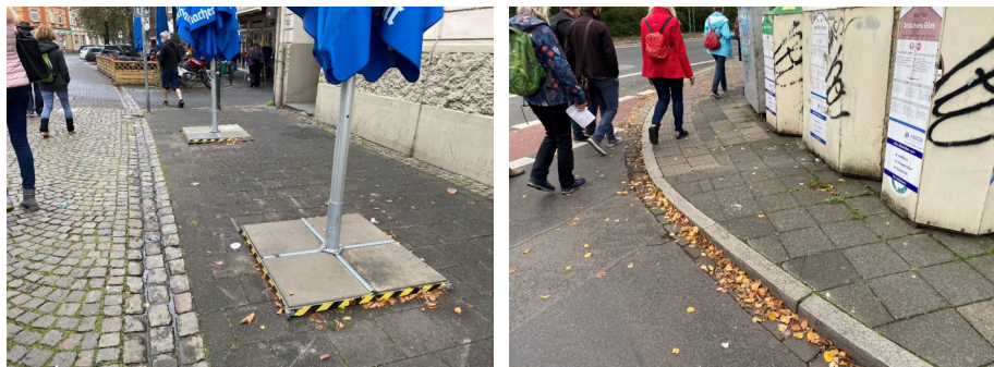
Abbildung 4-17: Barrieren auf den Nebenanlagen
