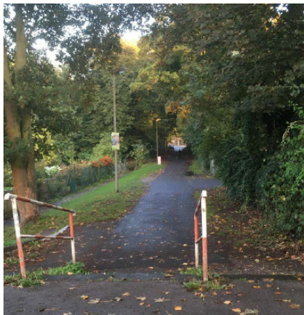
Abbildung 4-14: Treppenstufen sind nicht sichtbar und Rampe ist zu steil an der Friedrich-Wilhelm-Straße in Gerresheim
