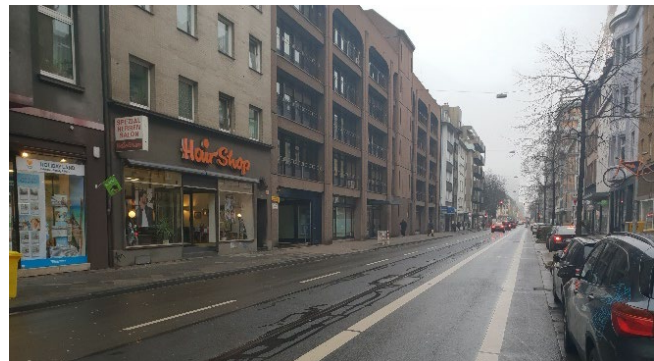
Abbildung 42: In einigen Straßen wurden daher beid- oder zumindest einseitig neue Radfahrstreifen angelegt
