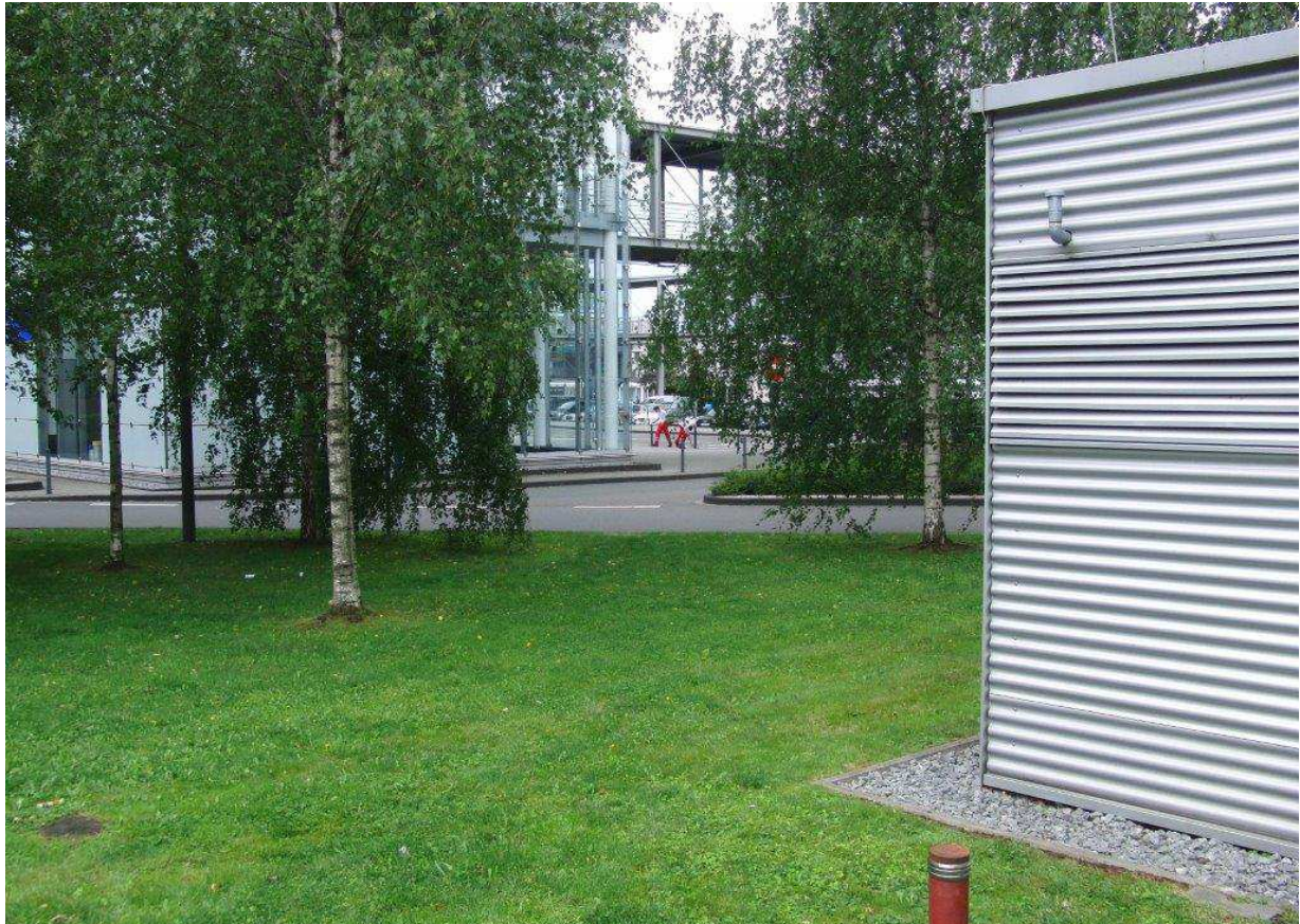
Foto 15: Blick von der Nordost-Seite des Hotels am Maritimplatz auf die Fußgängerbrücke im Bereich der alten Flughafenverwaltung.
