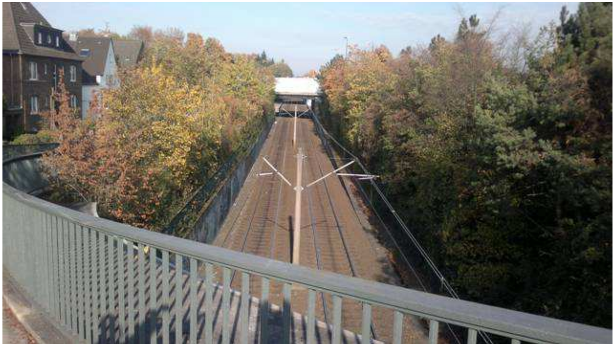
Foto 3: Blick von der Fußgängerbrücke (Lilienthalstraße / südlich A44) Richtung Norden
