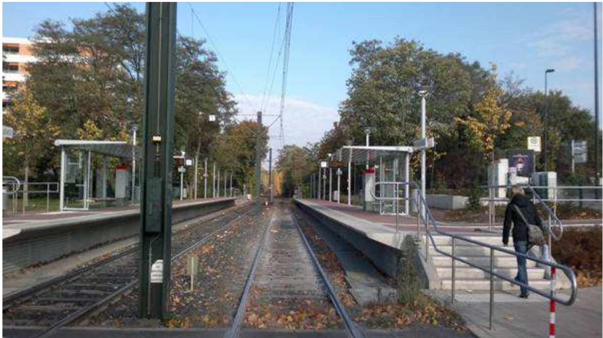
Foto 1: Stadtbahnhaltestelle Freiligrathplatz (U79) – Blick Richtung Norden
