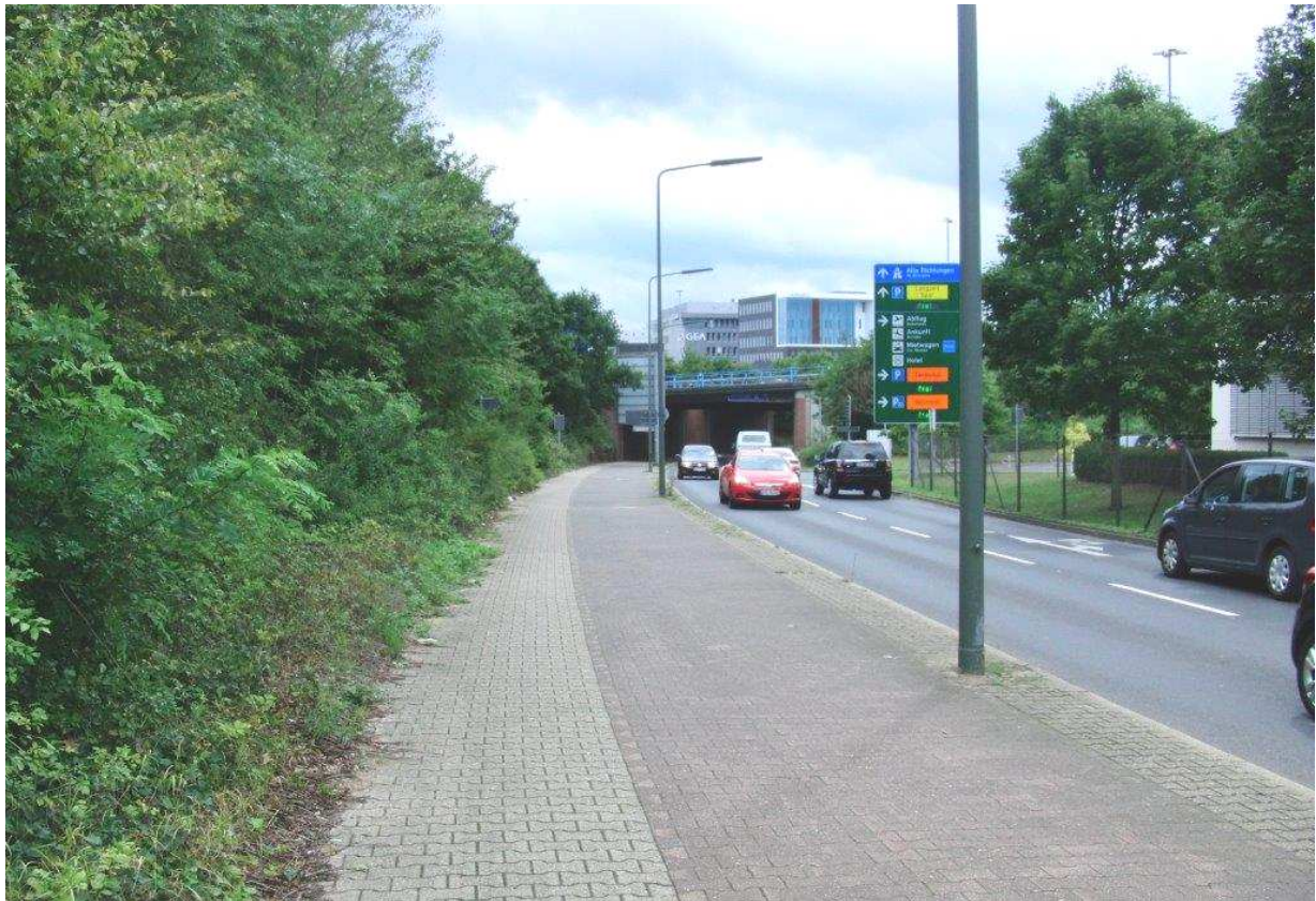
Foto 19: Blick auf den Terminal Ring Richtung Südwesten, im Hintergrund der Flughafenzubringer.
