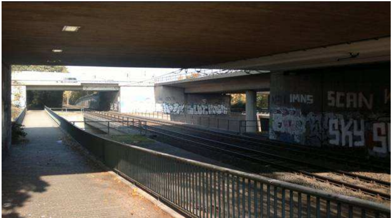
Foto 6: Verkehrsknotenpunkt Nordstern – Ebene Stadtbahn (U79), Blick Richtung Norden
