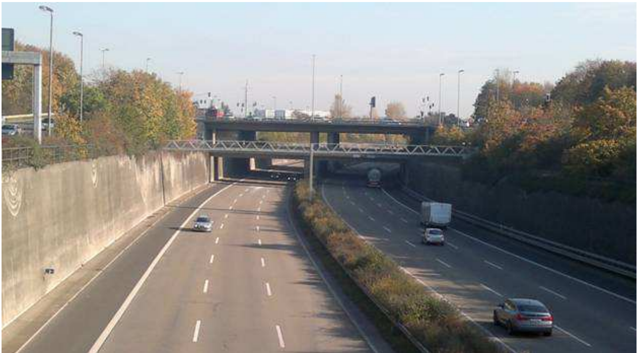
Foto 8: Blick auf die Troglage der A44
