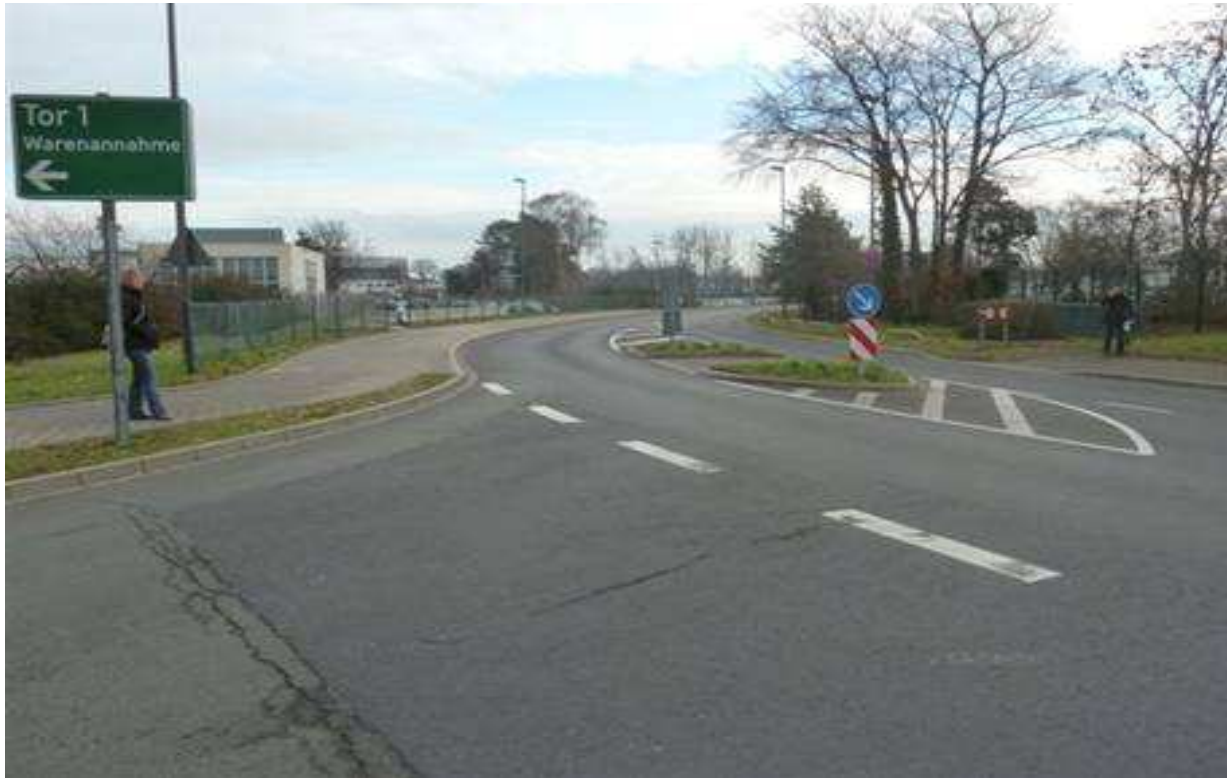
Foto 11: Flughafenstraße östlich der Feuerwehrawache
