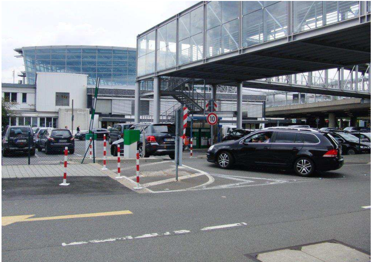
Foto 13: Blick auf die alte Flughafenverwaltung und Fußgängerbrücke.
