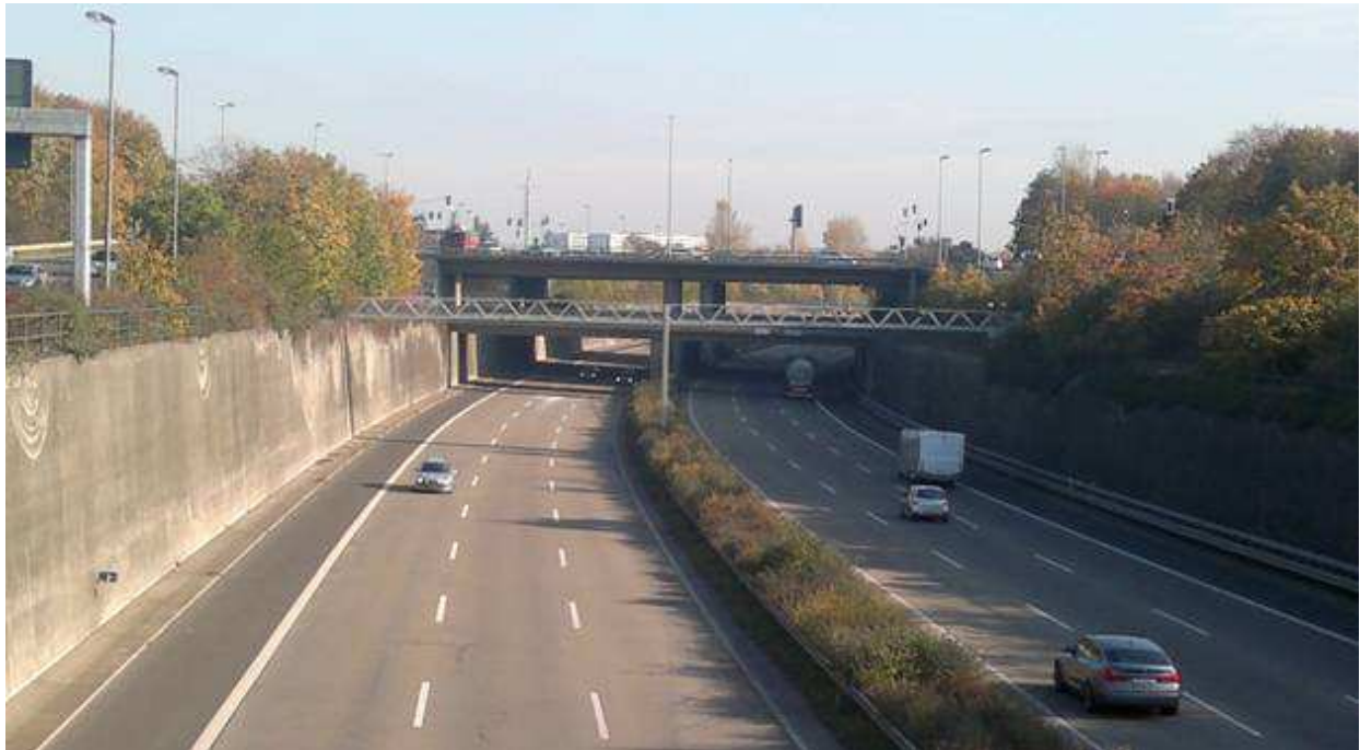
Foto 8: Blick auf die Troglage der A44
