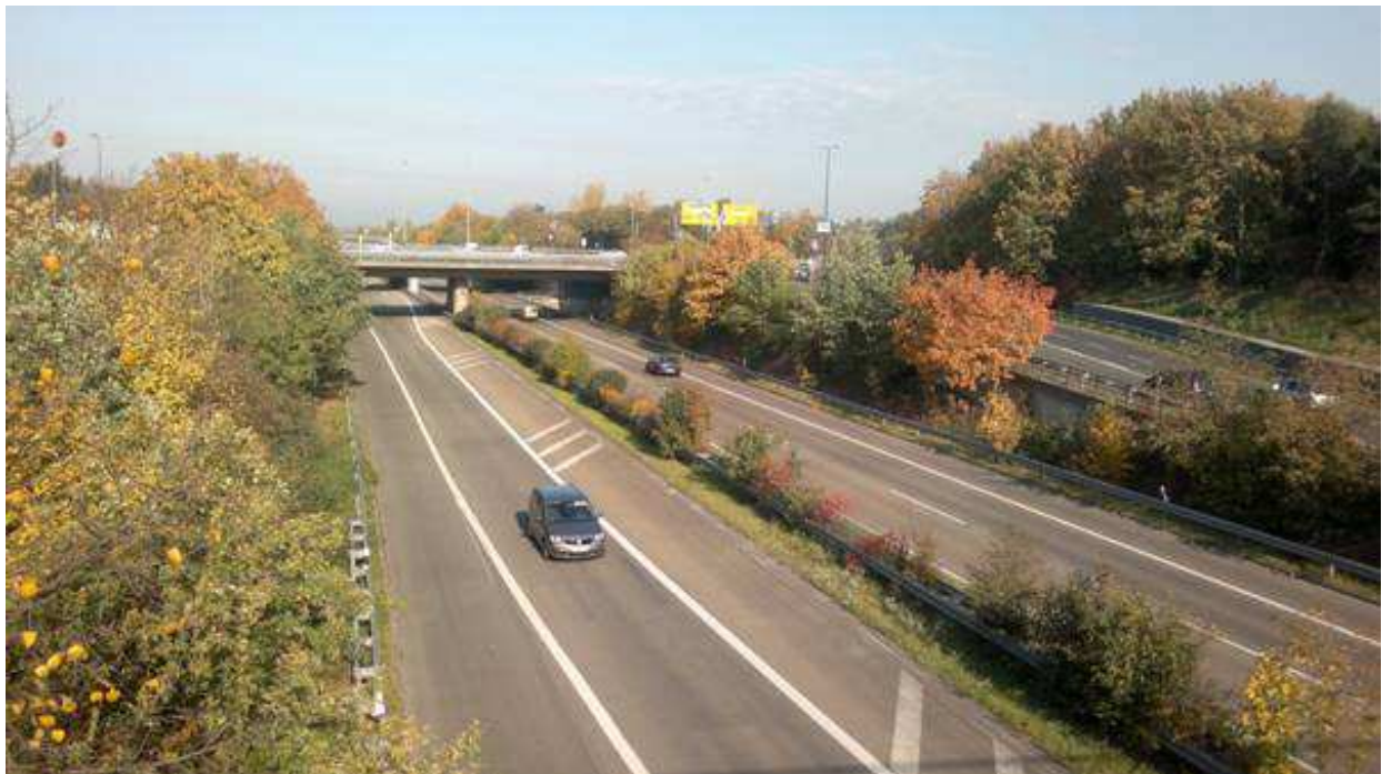
Foto 4: Blick von der Fußgängerbrücke auf die B8 (Danziger Straße) Richtung Norden
