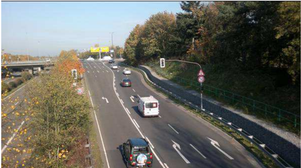
Foto 5: Ausfahrt B8 – im Hintergrund der Verkehrsknotenpunkt Nordstern
