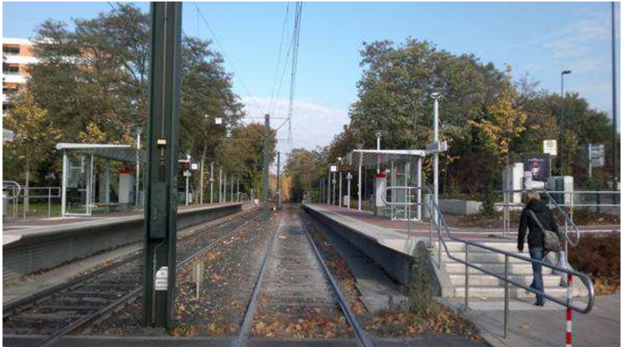
Foto 1: Stadtbahnhaltestelle Freiligrathplatz (U79) – Blick Richtung Norden
