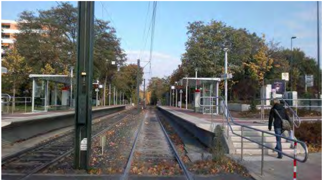
Foto 1: Stadtbahnhaltestelle Freiligrathplatz (U79) – Blick Richtung Norden
