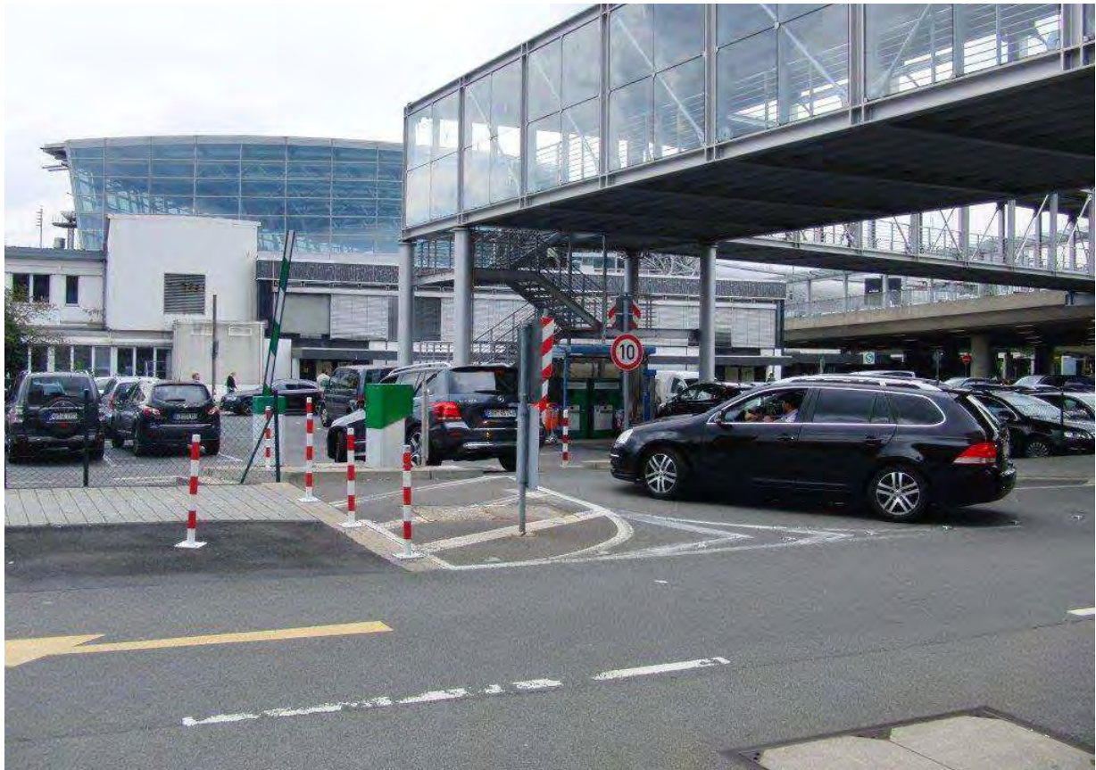
Foto 13: Blick auf die alte Flughafenverwaltung und Fußgängerbrücke.
