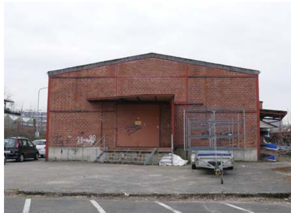
Lagerhalle des Leistungssportzentrums für Ruder- und Kanuvereine
