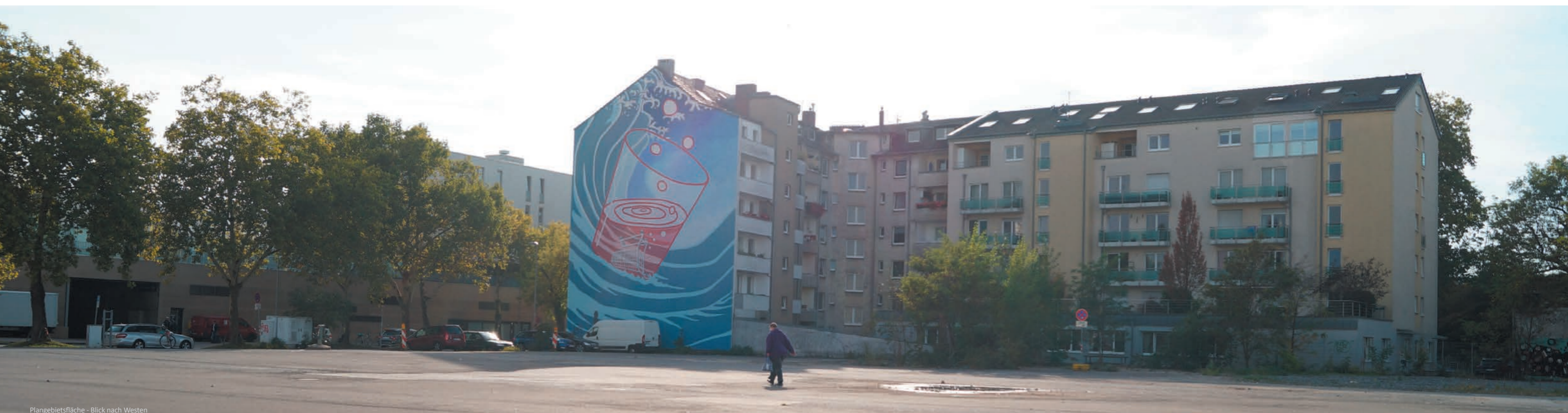
Plangebietsfläche - Blick nach Westen
