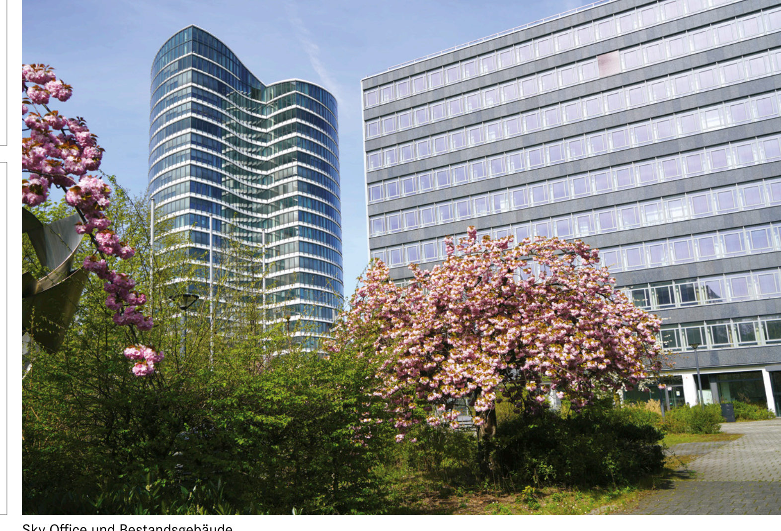
Sky Office und Bestandsgebäude
