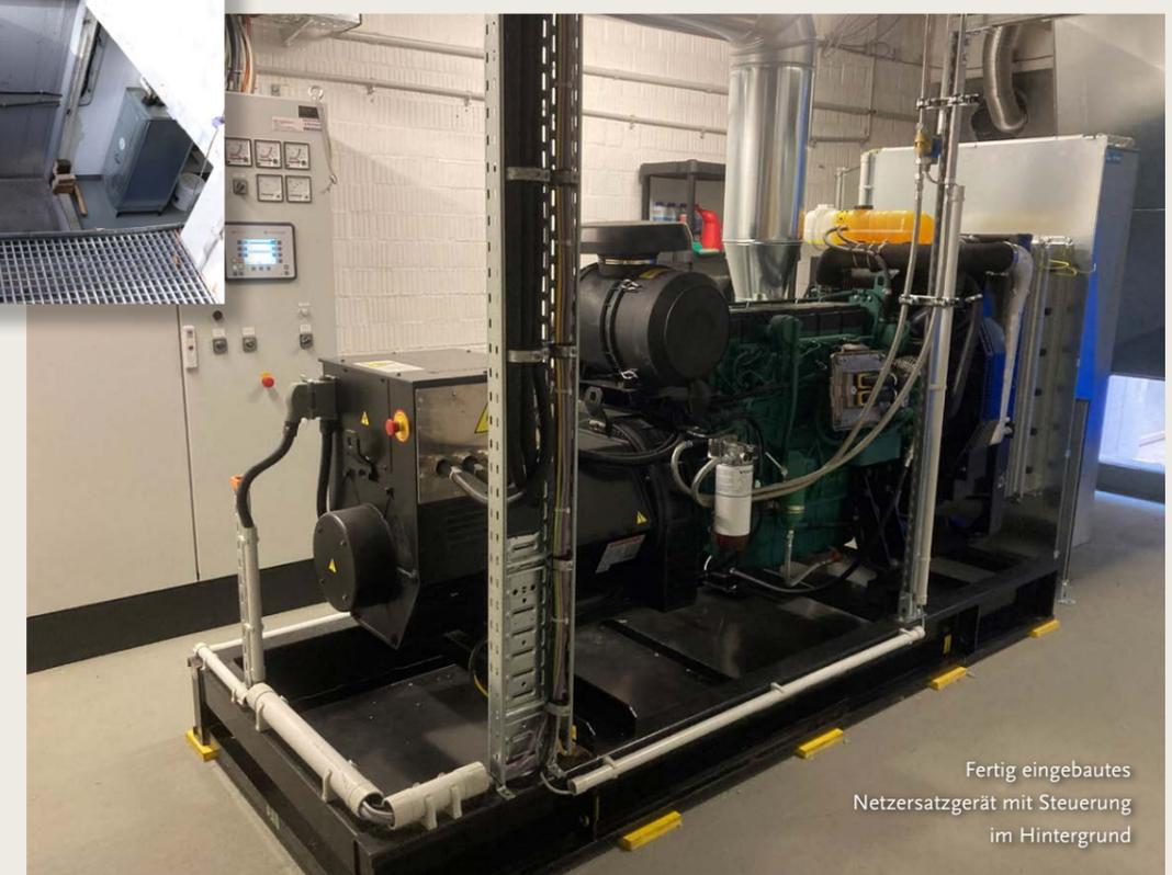
Fertig eingebautes Netzersatzgerät mit Steuerung im Hintergrund
