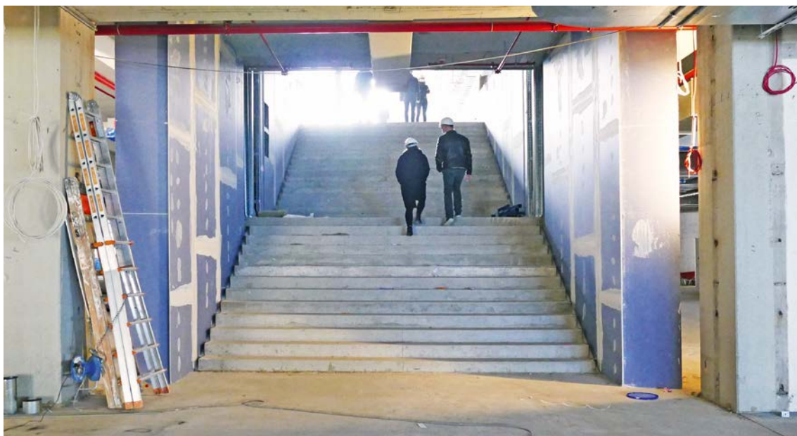
Der Treppenaufgang im Bau, 2020
