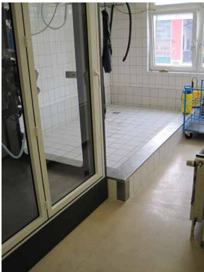
Das Vorreinigungsbecken nach dem Umbau.
