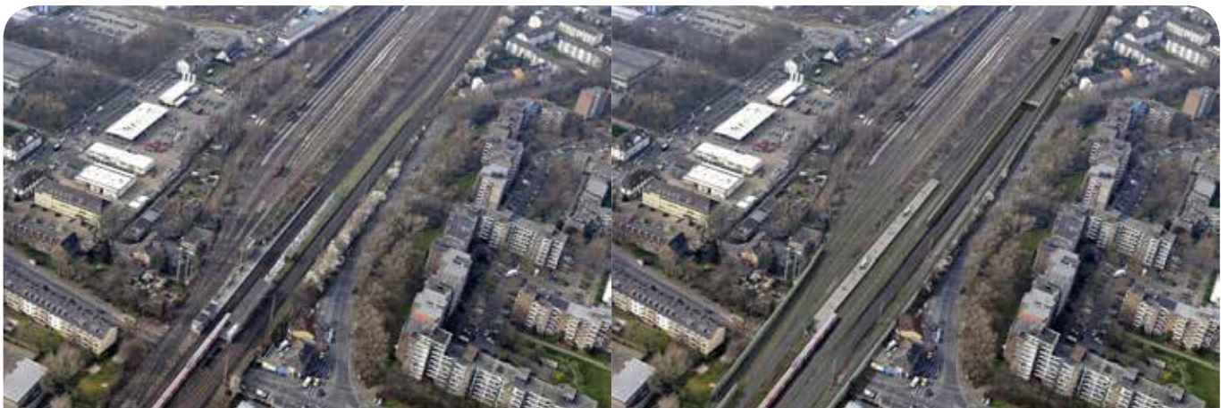
links: aktuelles Bild ohne RRX; rechts: Lärmschutzbauten für die Bahnstrecke. Foto: DB-Netz AG
