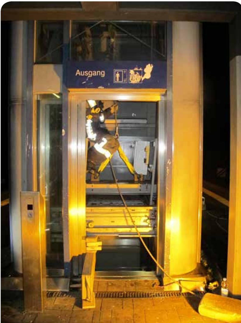
Drei Stunden dauerte die Rettung von vier Jugendlichen am 9. Oktober aus diesem Aufzug. Der Aufzug ließ sich auf dem üblichen Wege nicht verfahren. Auch die Wartungsfirma konnte nicht helfen. Daraufhin wurde die Fahrgastkabine mit einem Greifzug angehoben. Die Jugendlichen haben die Zeit im Aufzug gut überstanden.
