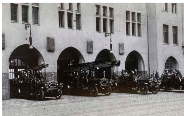
Vollelektrifizierter Löschzug an der Feuerwache Münsterstraße.
