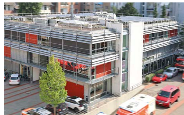
Das Führungs- und Lagezentrum der Feuerwehr Düsseldorf an der Hüttenstraße
