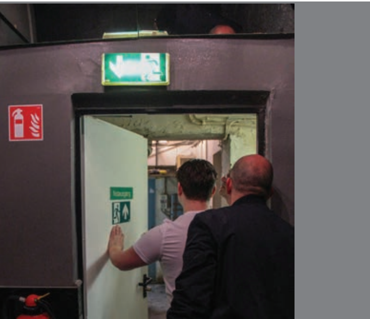
Schwierig für den Brandschutz: Die Katakomben der Düsseldorfer Altstadt
