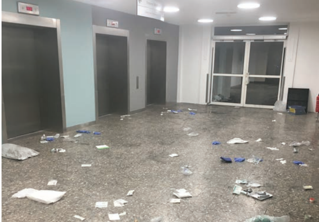
Die Patientenablage im Bereich des Aufzugsvorraumes
