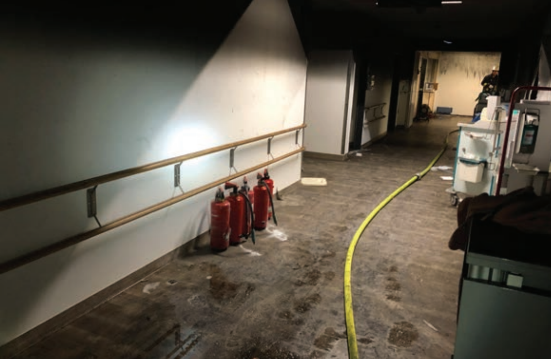
Die ersten Löschmaßnahmen fanden mit Feuerlöschern der Station 2A statt
