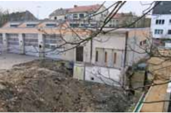
⬆️ ABRISS DES ZWISCHENTRAKTES, 2006
