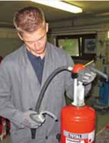
Öffnen des zu prüfenden Feuerlöschers
