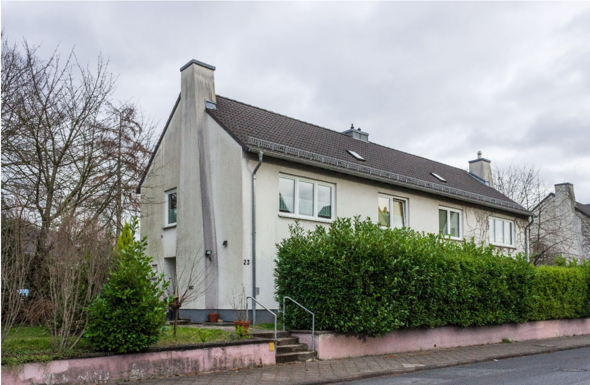
Abbildung 5: hervorstechender Kamin Lohausen Dorfstraße 23
