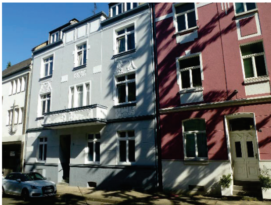
Abbildung 8: Ottostraße 5 und 7 (Stadtplanungsamt, Aufnahme vom 09.08.2022)
