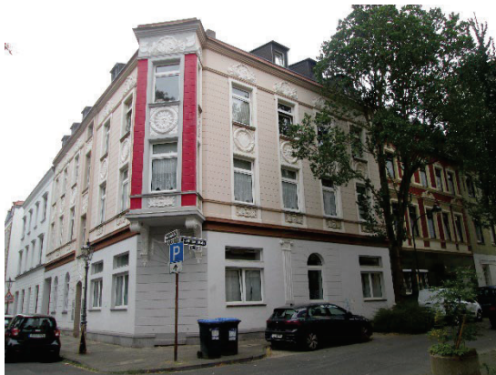
Abbildung 3: Vereinsstraße 17 an der Kreuzung zur Hardenbergstraße (Stadtplanungsamt, Aufnahme vom 15.08.2022)
