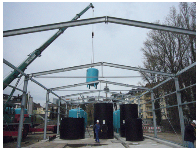
Bau Grundwassersanierungsanlage Martinstraße, Aufstellen der Behälter
