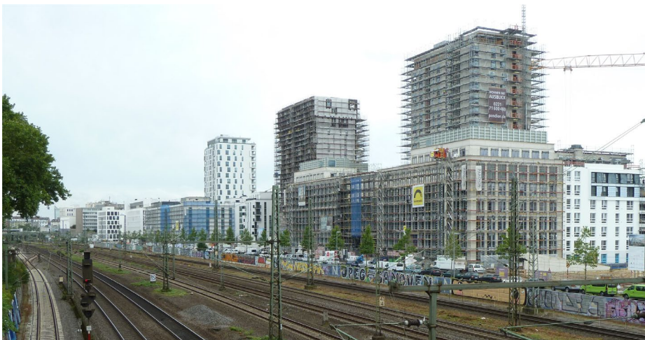
Abbildung 3: Neubauprojekt ehem. Güterbahnhof Derendorf
