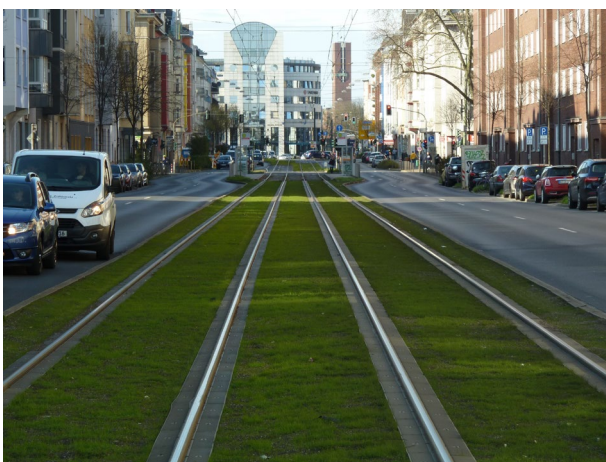
Abbildung 5: Neuer Rasengleisabschnitt an der Dorotheenstraße
