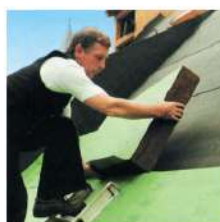
Aufsparrendämmung
