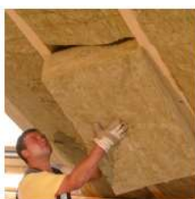
Zwischensparrendämmung
