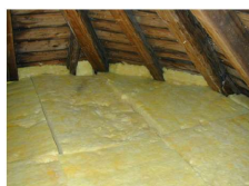
Dämmung oberste Geschossdecke
