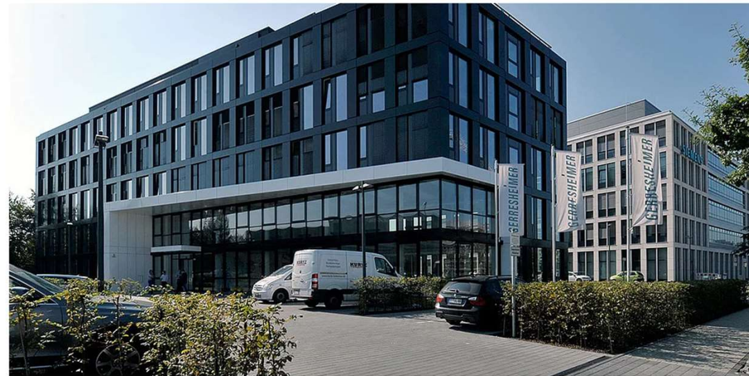
Neun in Kaskade geschaltete Wärmepumpen beheizen das neue Bürogebäude in der "Airport City" in Düsseldorf (Foto: Mitsubishi)
