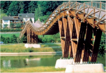
Unzählige Festmeter von wasser- und schädlingsresistentem Bongossi-Holz wurden von deutschen Wasserbauern verbraucht.
