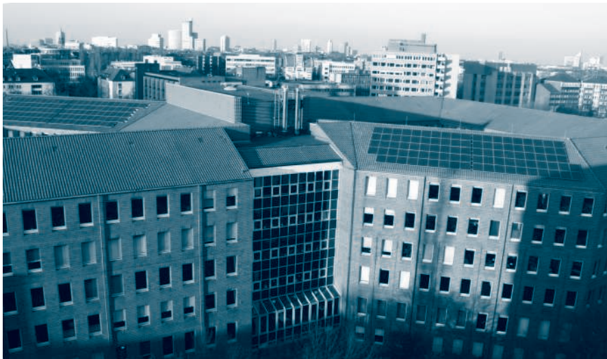
Solaranlage auf dem technischen Rathaus in Bilk
