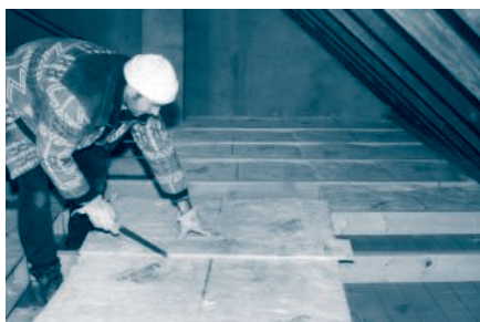
Isolierung der Außenwände und des Dachs – eine Arbeit, die lohnt
