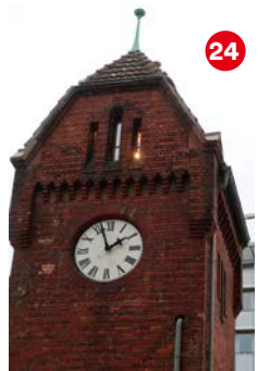
Der Turm der Haniel-Lueg'schen Eisenwerke wirkt auffällig in den Straßenraum. © Alde Düsseldorfer Bürgergesellschaft 1920 e. V.
